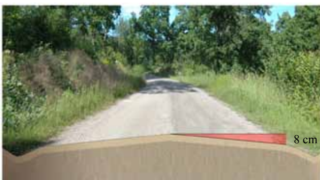
Bild 1: Tvärfall på rak sträcka. Vägens bredd = 4 m.
