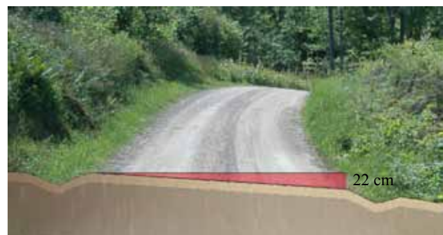
Bild 2: Skevning i kurva. Vägens bredd = 4 m.
