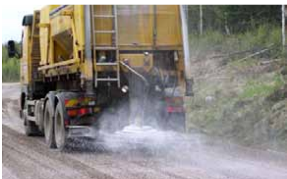
Bild 14: Spridning av flingor med kombispridare.
