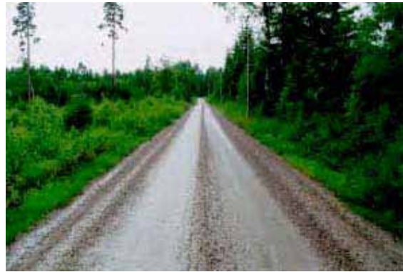
Bild 8: Löst grus på vägbanan
